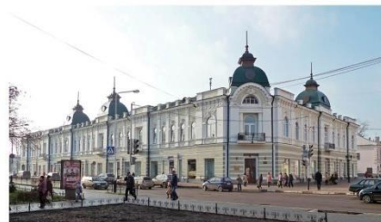
Дом Шоршорова, общий вид, после реставрации
